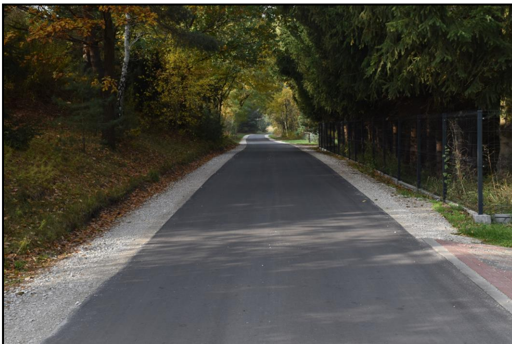
Zdjęcie 3. Przebudowa dróg gminnych w 2024 r. odbywała się z dużym dofinansowaniem zewnętrznym
