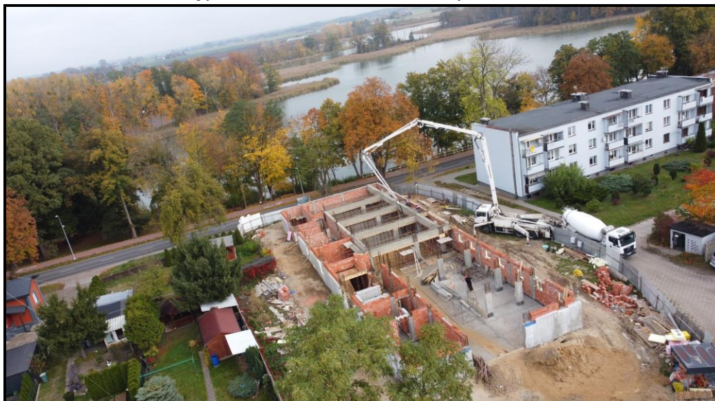
Zdjęcie 1. Budowa bloku w Chelmicy-Cukrowni
