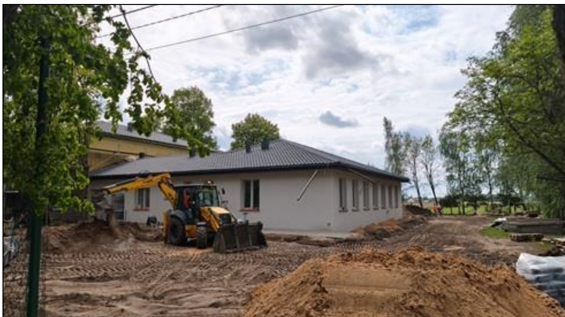
Zdjęcie 8. Rozbudowa budynku w Świątkowiznie na potrzeby CUS (wg stanu V 2026)
